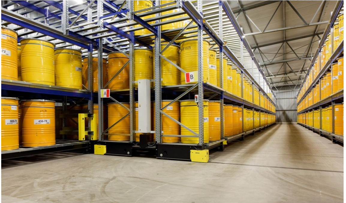
Bild 6 Det nya mobila höglagret i AU.
